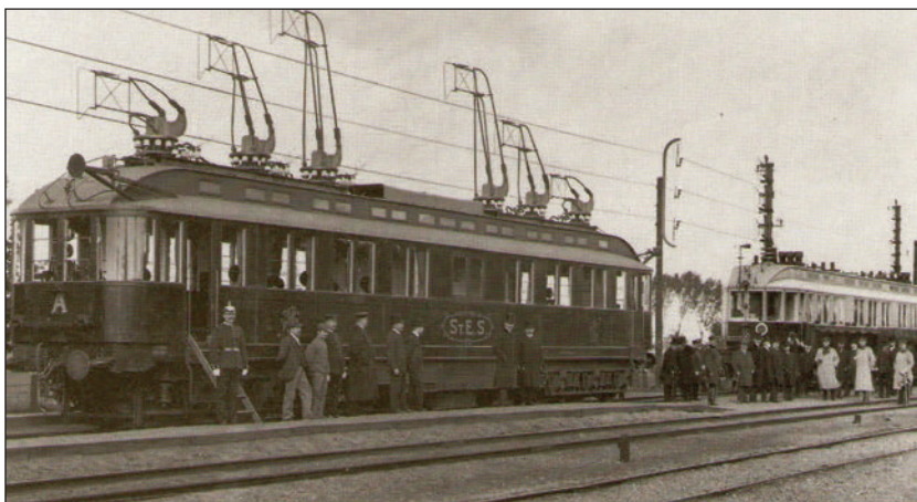
Der Triebwagen der Firma AEG erreichte 1903 den Weltrekord mit 210 km/h.
