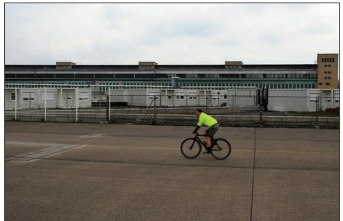
Sogenannte Tempohomes am Rand des Tempelhofer Feldes. Bald sollen neue dazukommen.
